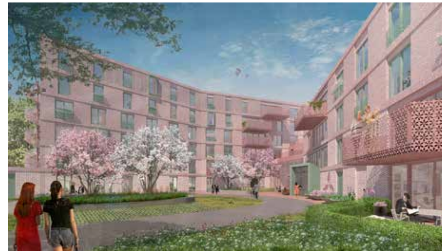
Zorgcomplex en expertisecentrum Thebe/GGz Breburg in Breda. (Beeld: SMT Bouw & Vastgoed)
